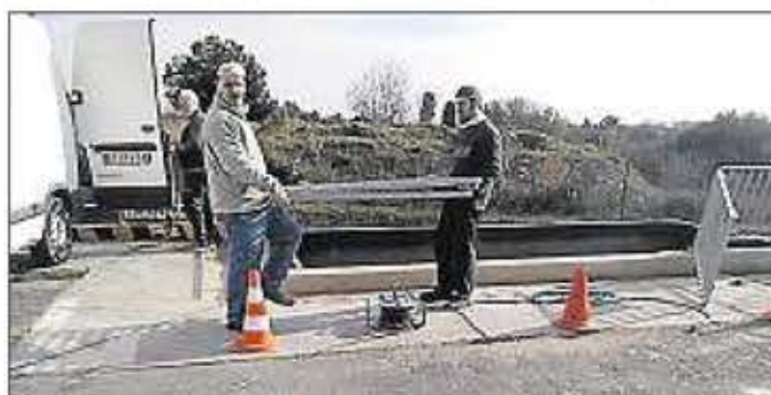
L'installation du système de barrière mobile.
